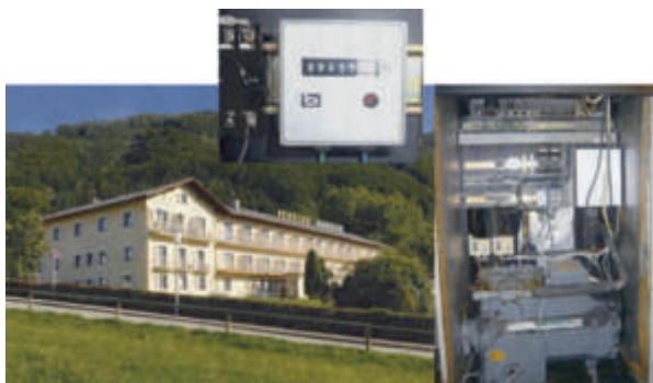
Ilustracija 10 Pogled na pansion 'Magerl', dugovječnu dizalicu topline i njezin brojač radnih sati
