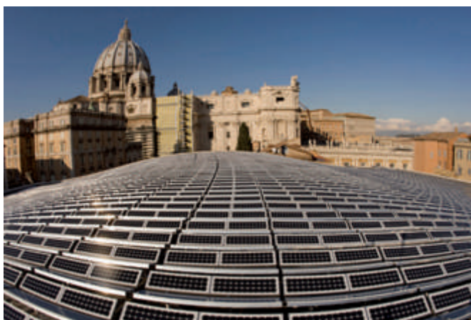
Ilustracija 3 Fotonaponski sustav na vaticanskim krovovima
