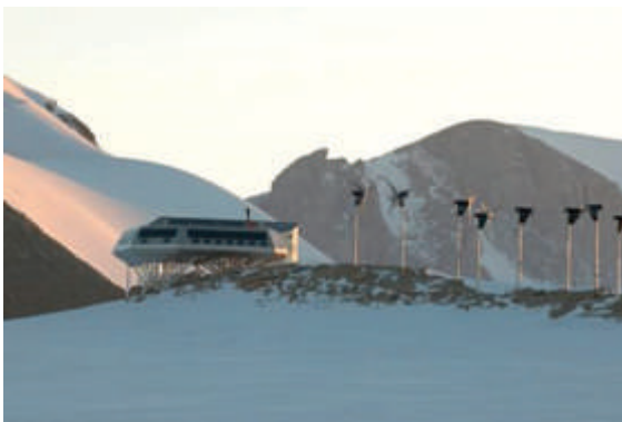
Ilustracija 6 Pogled na Međunarodnu polarnu stanicu Princeze Elizabete i postavljene vjetroturbine...
